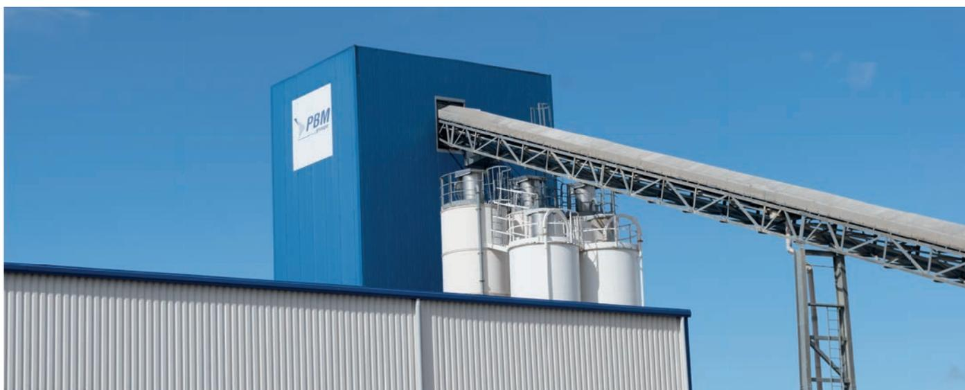
La centrale est équipée de deux malaxeurs de 1.5 m<sup>3</sup> chacun, permettant de réaliser en simultané les deux types de béton : béton ordinaire et béton de bois, avec une capacité centrale de 3 m<sup>3</sup> toutes les 5 minutes.
